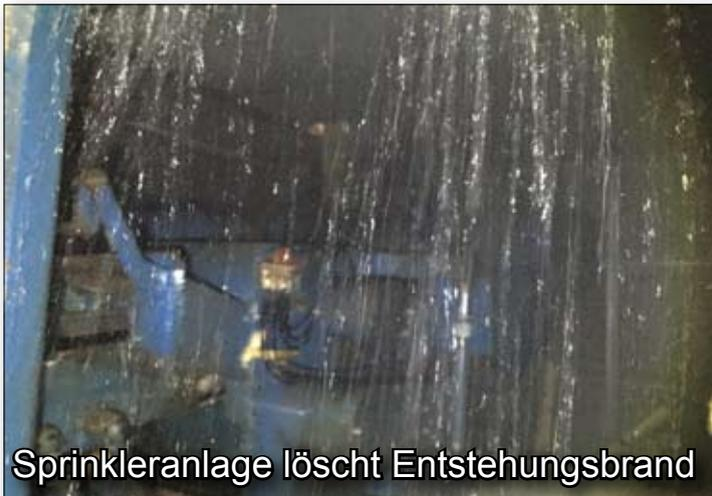
Sprinkleranlage löscht Entstehungsbrand
